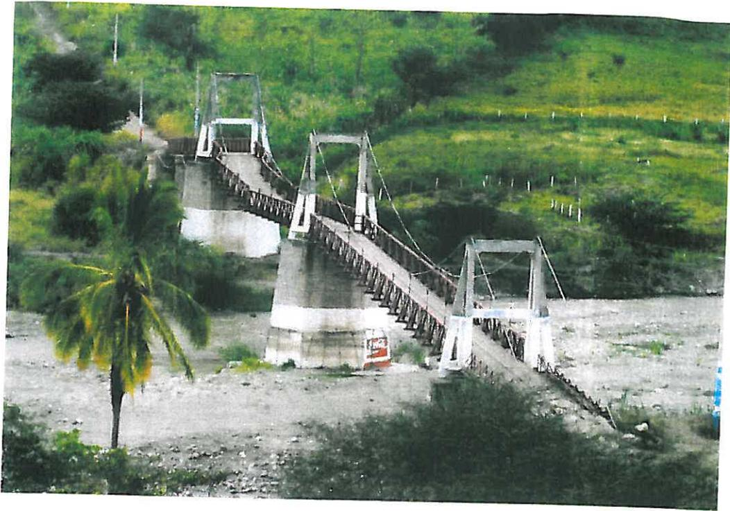
**Ilustración 2.- Puente del CREA, inhabilitado para dar servicio. Obsérvese, como el tramo que salva la corriente principal del río, se encuentra con graves daños estructurales.**
