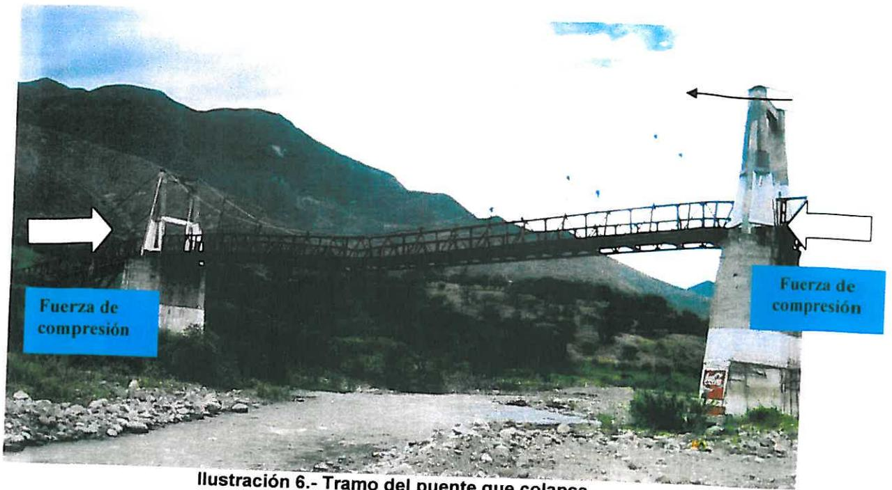
**Ilustración 6.- Tramo del puente que colapsa.**
