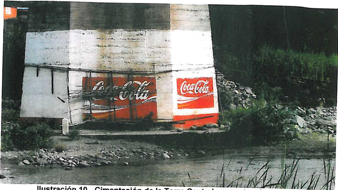
**Ilustración 10.- Cimentación de la Torre Central expuesta a la erosión.**
