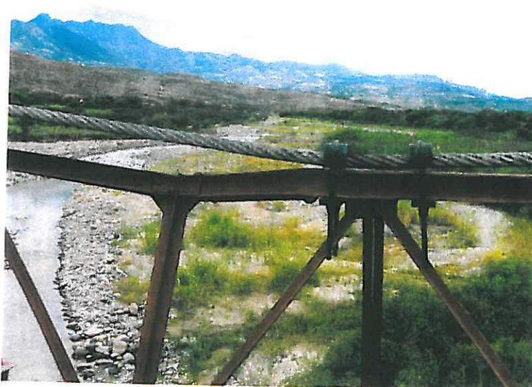
**Ilustración 5.- Abrazaderas que unen el cable con las cerchas. Tramo donde se presenta los daños.**
