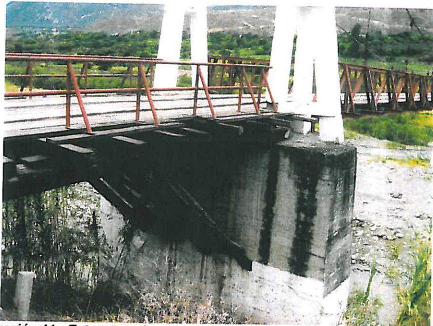
**Ilustración 11.- Estructura de madera del acceso completamente deteriorada.**
